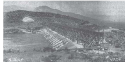
Barahona Tailings Dam - Rancagua - El Teniente Mine
