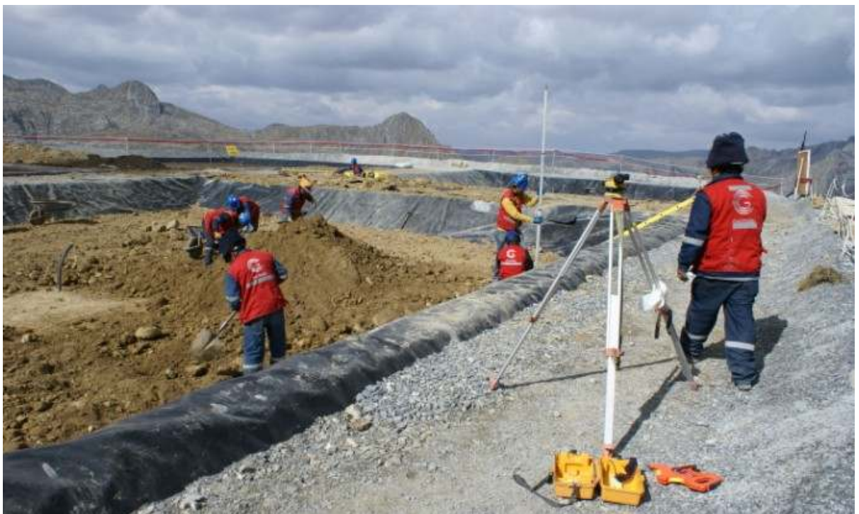
Photo #36: Leveling clayey till in lysimeter #1.
