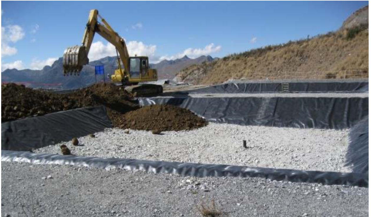
Photo #36: Leveling clayey till in lysimeter #1.
