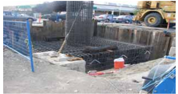
Photo 4. Pile cap rebar fabrication
